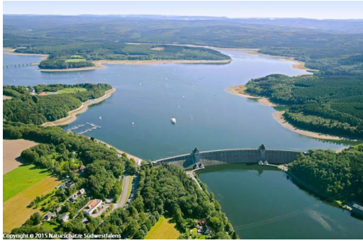
Gang über die Sperrmauer
